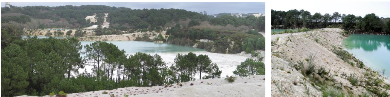
Figure 6 : Lagune de Kerourant (gauche) et sa digue (droite)
